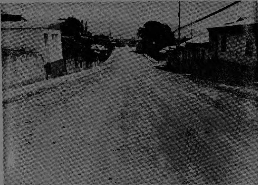
ULTIMO TRAMO de la calle ancha, que circunvala a la ciudad de Alajuela. La gráfica muestra que recién se ha terminado la primera etapa de ampliación y lastreado, para luego el correspondiente asfaltado. Esta vía resuelve el congestionamiento del tránsito en Alajuela.
